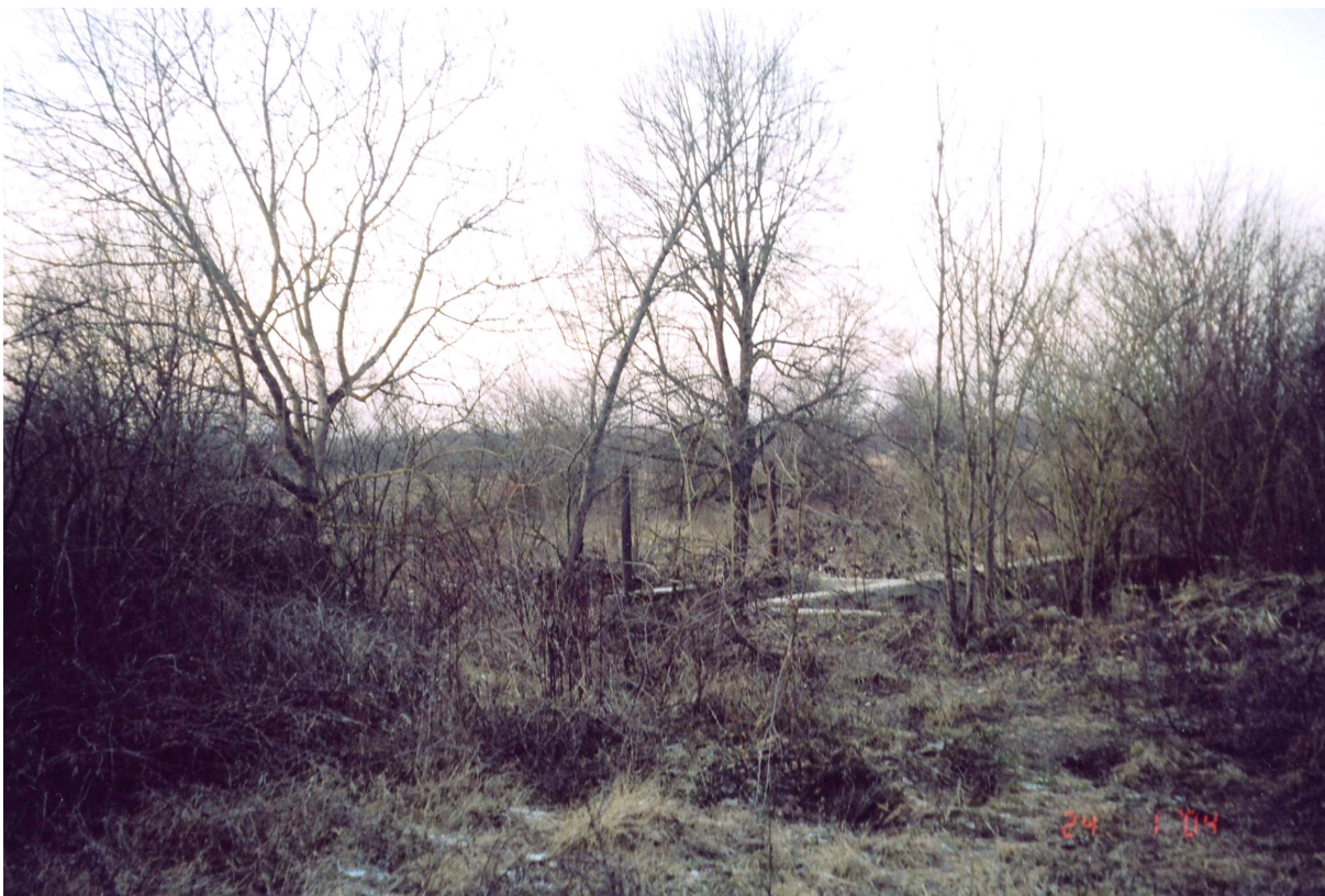
Slika 36: Nakon rušenja građevinski materijal (cigle) je razgrabljen, fotografirano 24. siječnja 2004.
